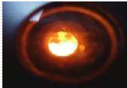
炉内の燃焼状態
